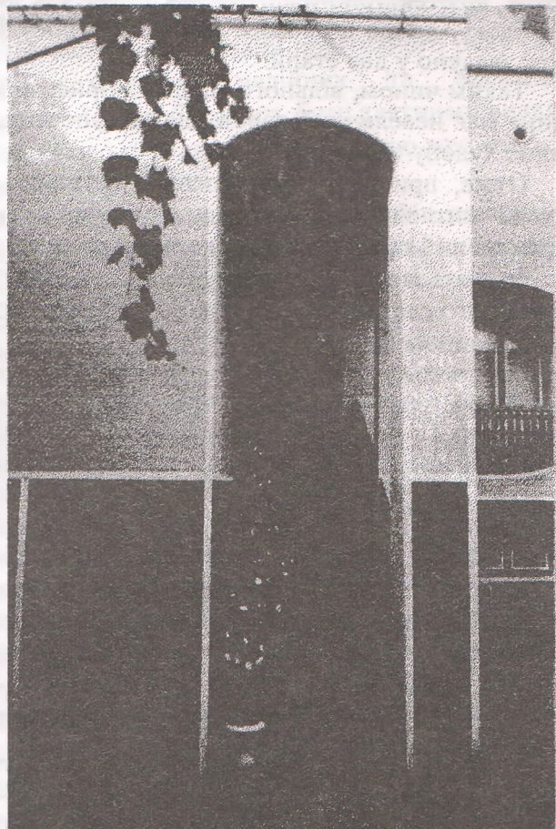
Фрагмент фасаду будинку № 19 по вул. Чкалова, м. Хуст Закарпатської області
