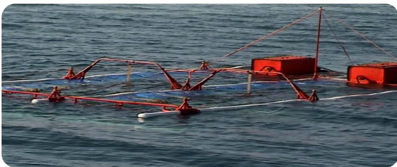
Рис. 2. Хвильова електростанція з гнучким енергопоглинальним елементом
