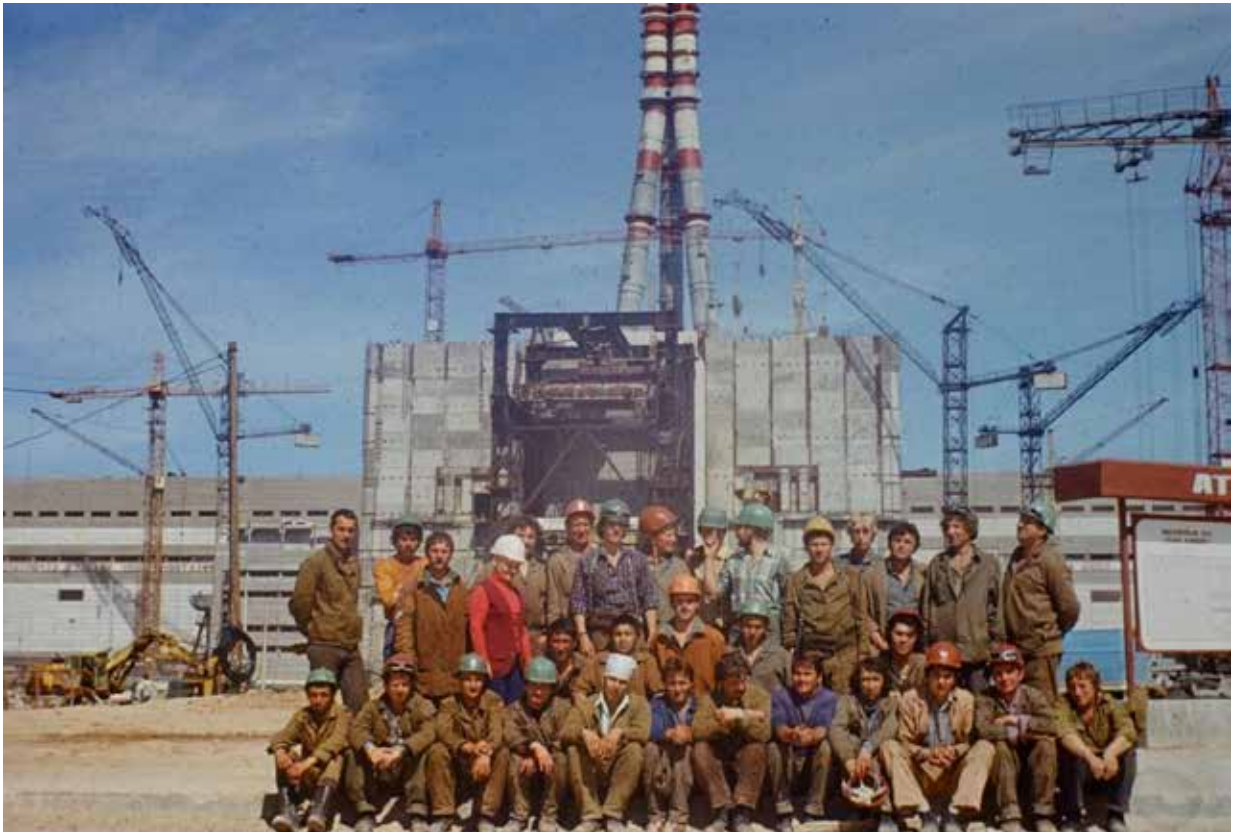
Рис. 1. Ігналінська атомна електростанція. Бригада монтажників Джерело: Вісагінаський міський музей, фотограф Василій Чіупаченко.
