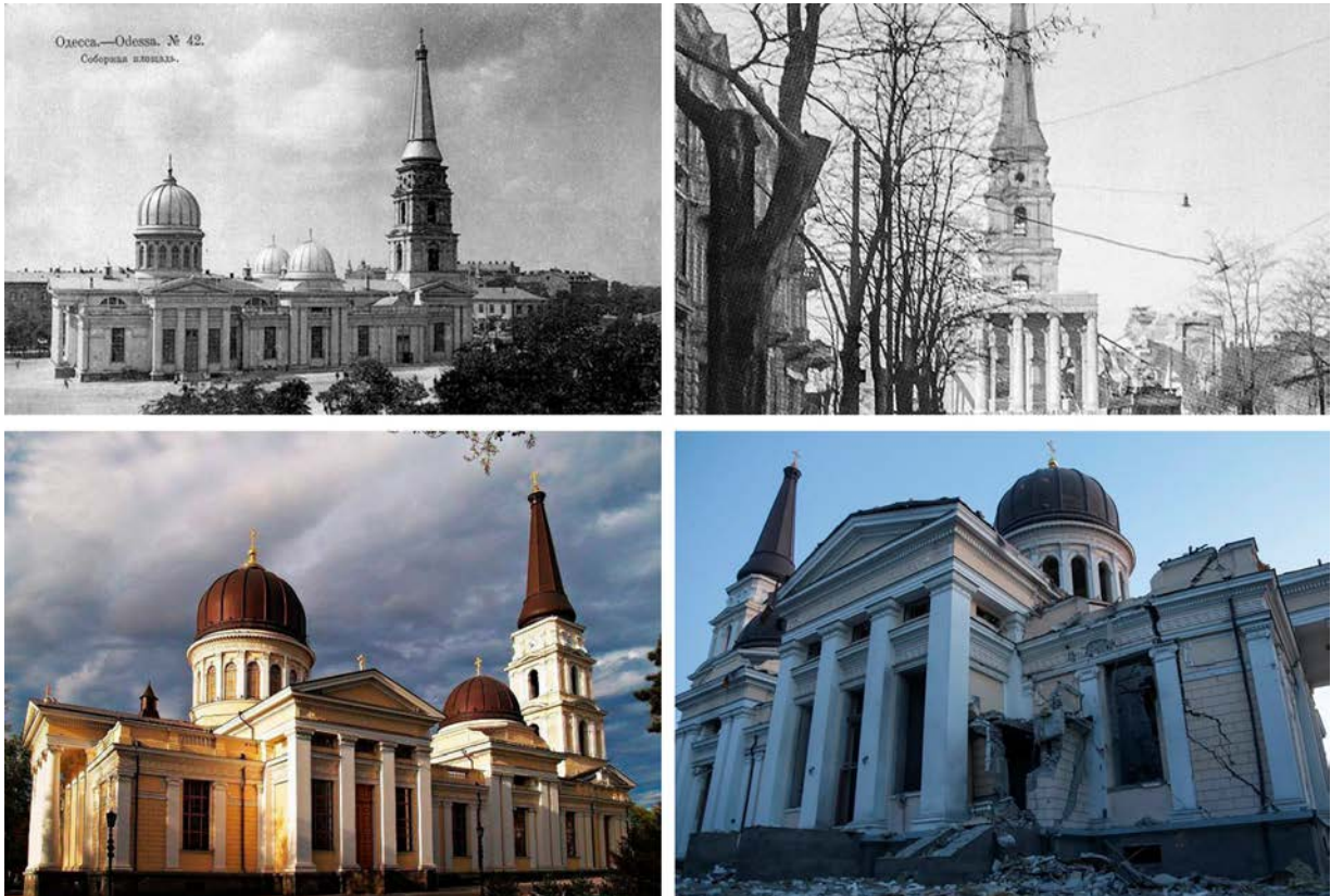
Рис. 4. Відтворення Спасо-Преображенського собору в Одесі, 1999–2010 рр. Вигляд до руйнування (1888 р.), напівзруйнований собор (1936 р.), відтворений собор (фото між 2010–2023 рр.), руйнування від ракетного удару (2023 р.)
