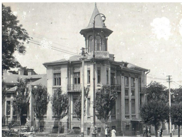
Рис. 2. Особняк інженера Непокойчицького, збудований у 1913 р. (м. Дніпро, вул. Шевченка, 33, пам'ятка архітектури)
