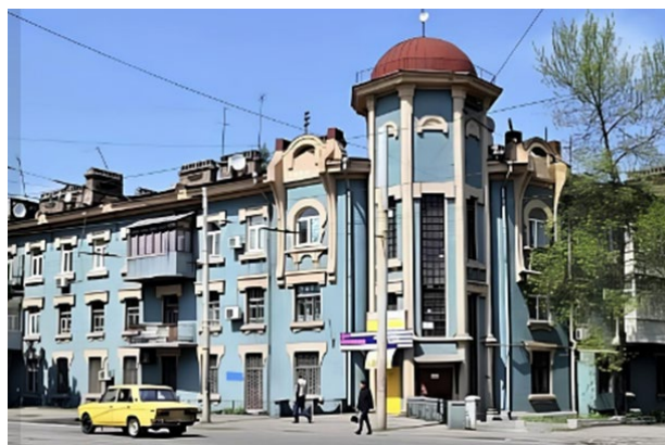
Рис. 3. Будинок, побудований для інженерно-технічних робітників металургійного заводу, початок XX ст. (пам'ятка архітектури)
