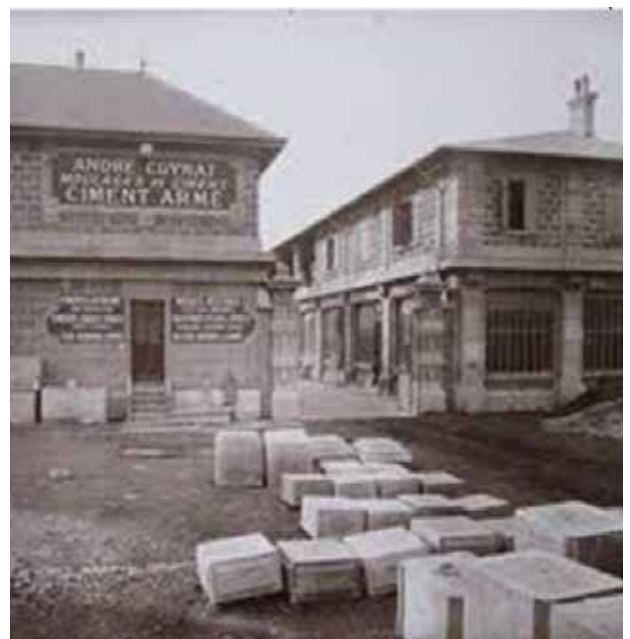
Рис. 2. Виготовлення блоків із романцементу у Франції XIX ст. Джерело https://hal.science/hal-01872660v1/document
