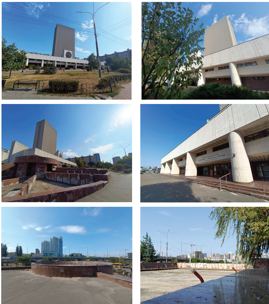
Рис. 2. Будівля, в якій розміщується НБУВ, та міське середовище, що її оточує: сучасний стан. Фрагменти фотофіксації, серпень, 2024 р.
