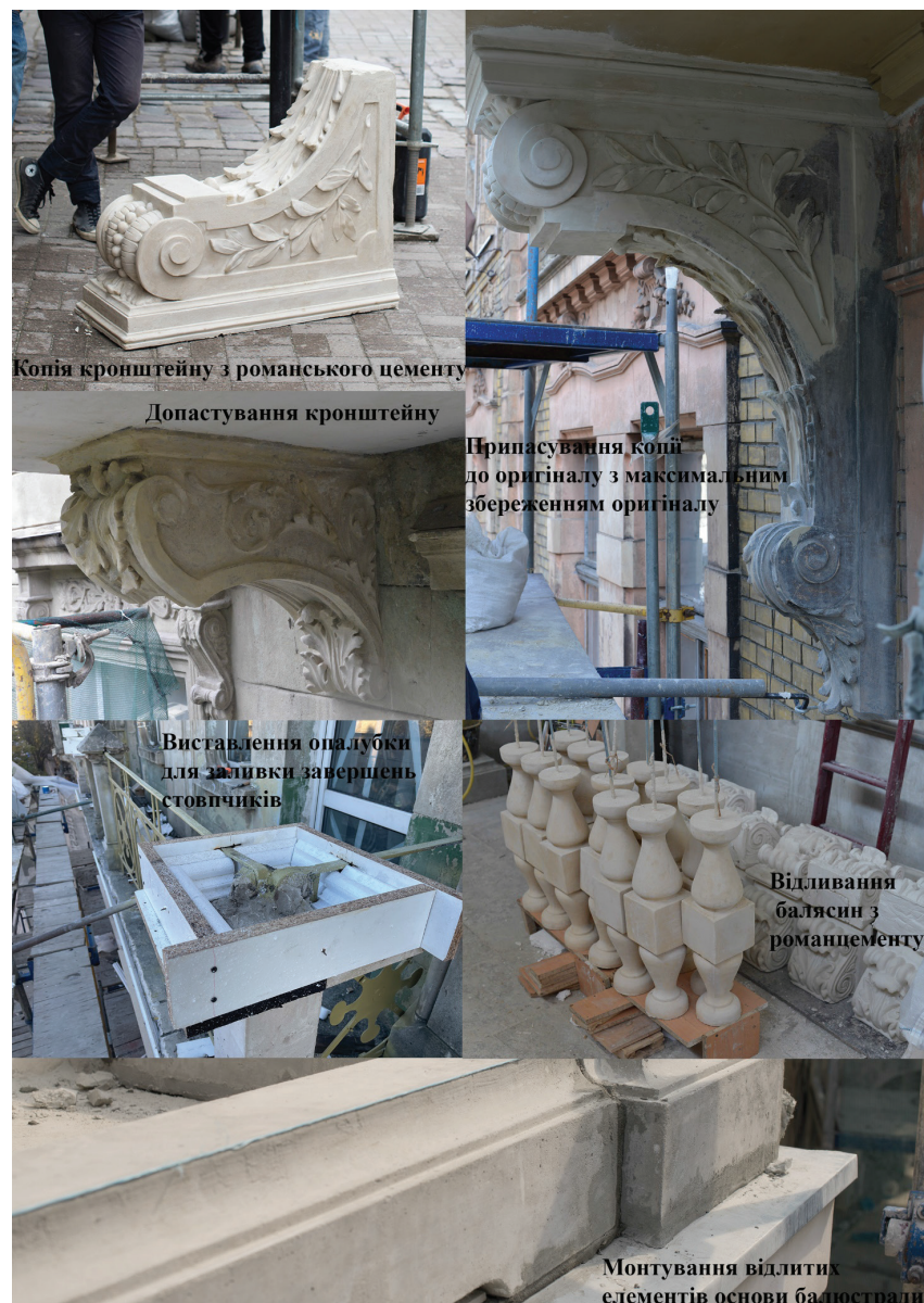
Рис. 4. Відновлення кронштейнів та огорожень
