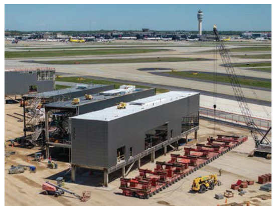
Рис. 2. Перевезення одного з модулів до зали D
