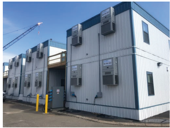
Рис. 1. Комплекс модульних будівель Wilmot в міжнародному аеропорту Даллеса
