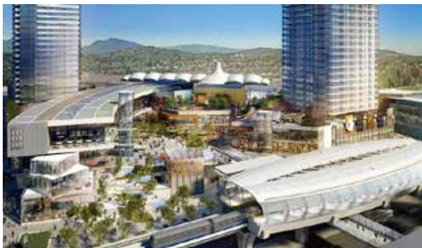
Рис. 2. Торговий центр Brentwood у Бернабі, Британська Колумбія, трансформований під багатофункціональний комплекс 2008 році [19]
