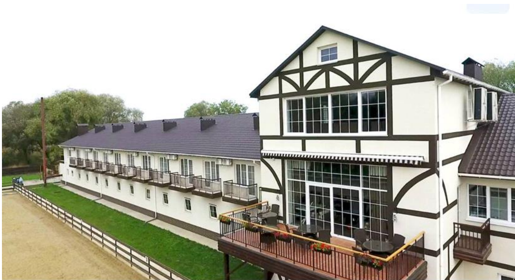
Рис. 1. Готельний комплекс кінноспортивного клубу «Тамерлан» в місті Хмельницькому зі стайнями в першому поверсі
