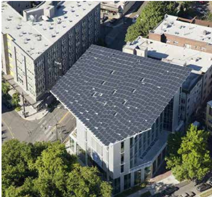
Рис. 3. Сонячні панелі на даху Bullitt Center (Сіетл, США)
