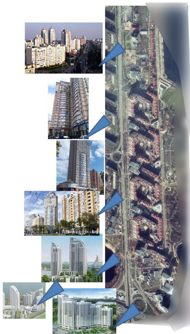
Рис. 2. Композиція просп. В. Івасюка – МЖК Оболонь. Послідовність композиції лінійних 12-поверхових лінійних будинків і точених 25-поверхових акцентних будинків
