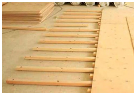
Рис. 4. Укладання підлоги на дерев'яні лаги
