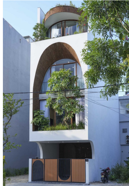
Рис. 2. Зелена зона на фасаді будинку
