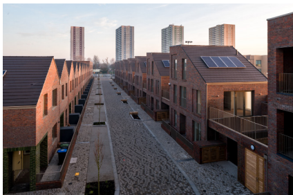
Рис. 12. Малоповерхова житлова забудова підвищеної щільності. Claredale Street, Лондон, Велика Британія
