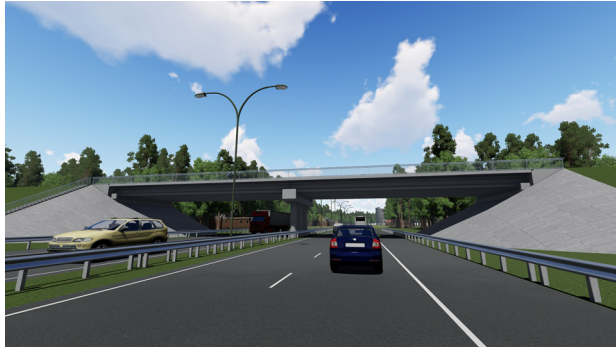
Рис. 3. Типовий двопрогоновий шляхопровід через автомобільну дорогу
