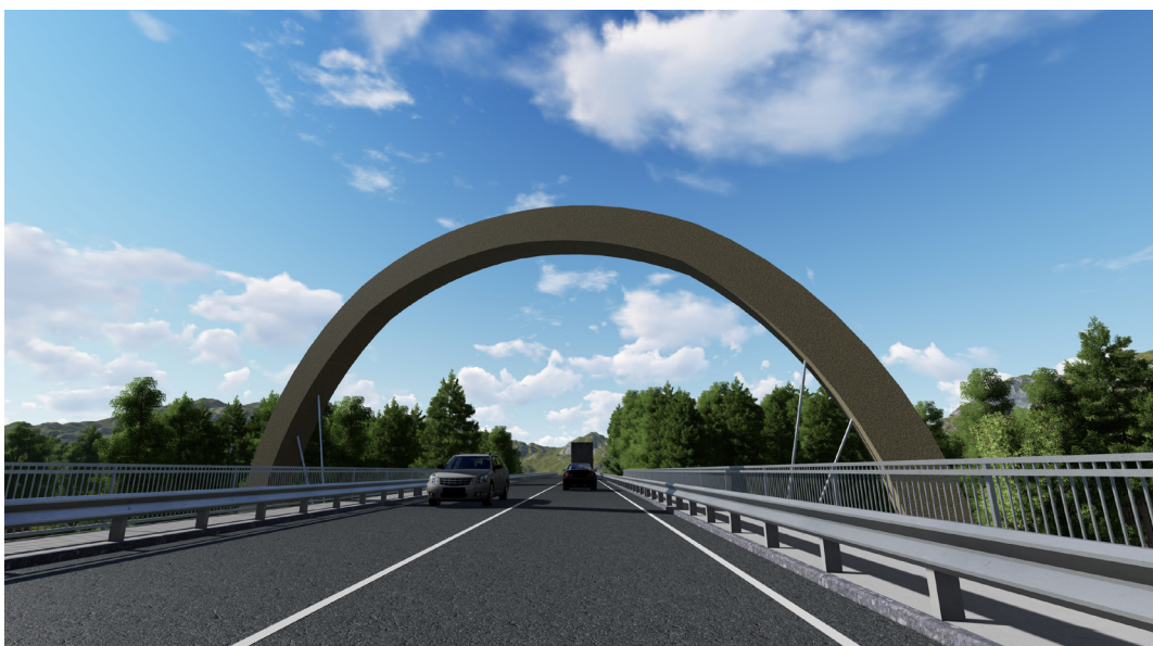
Рис. 7. Псевдоконструкція у вигляді арки з їздою посередині (вид з проїзної частини моста)
