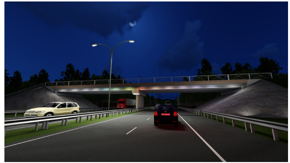
Рис. 2. Підсвічування елементів шляхопроводу для виявлення конструкції споруди
