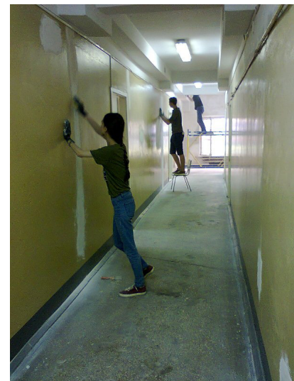
Рис. 12. Навчальний корпус №17, виконання ремонтних робіт студентами НАУ, 2019 рік. Фото Г. Агєєвої
