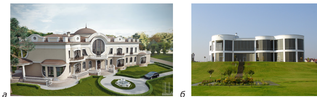
Рис.4. Круглі приміщення добре прочитуються на фасадах сучасних будівель:
