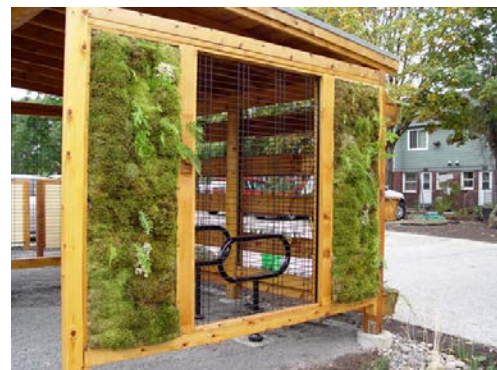
Рис.12а. Модернізація зупинки з використанням фітостіни
