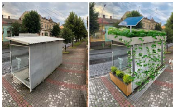
Рис.12. Модернізація зупинки з використанням звичайної технології вертикального озеленення
