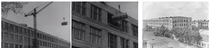
а) процес будівництва б) процес будівництва головний фасад в) загальний вигляд комбінату
