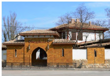
Рис. 1. Ресторан «Джеваль»: вхідна група та будівля ресторану у глибині двору, м. Євпаторія, 2009 р.
