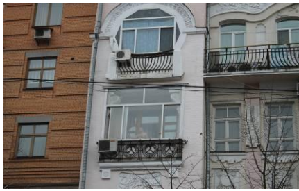
Рис. 5. Потворна заміна круглої форми вікна на багатогранну внаслідок використання пластикової рами з примітивною внутрішньою структурою (Володимирська, 81) та в різнобій засклені балкони, що порушують цілісність фасаду (Воровського, 7).
