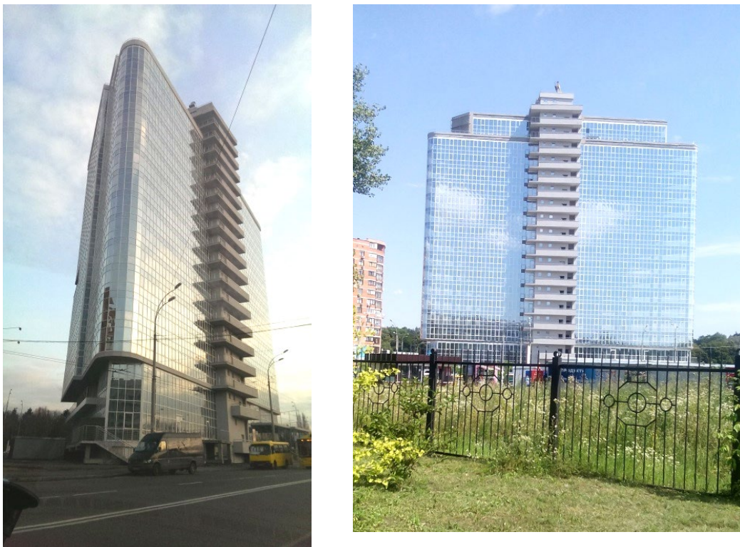
Рис. 3. Офісний центр по вул. Васильківській, м. Київ
